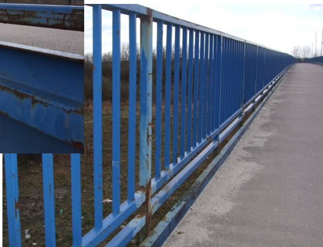
Widoczna uszkodzona powłoka antykorozyjna balustrad i przyległych stalowych elementów
