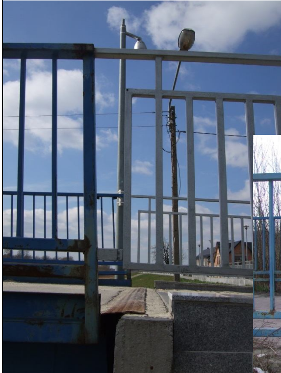
Widok na dylatacje podporowe od strony Mielca i Podleszan
